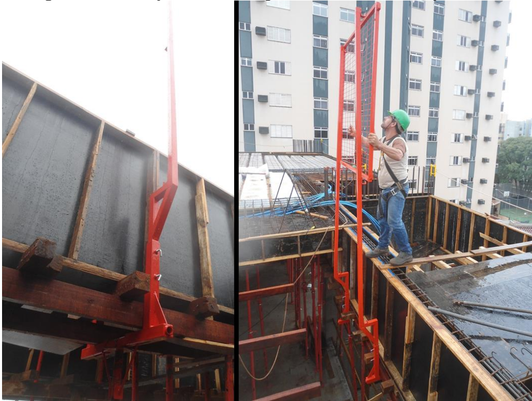
Figura 13 – Utilização do GcR em garfo metálico em edificação vertical
