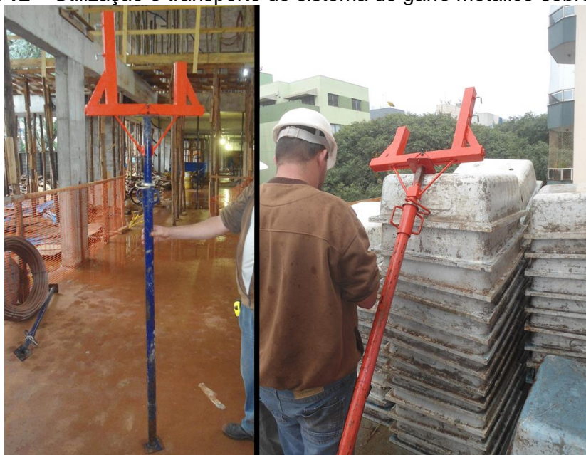
Figura 12 – Utilização e transporte do sistema de garfo metálico sobre escora
