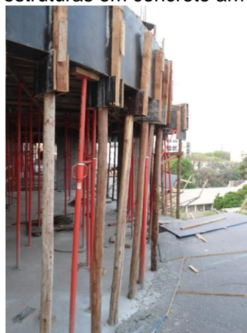
Figura 11 – Garfos de madeira frequentemente utilizados na produção de estruturas em concreto armado
