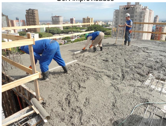
Figura 2 – Falsa impressão de segurança pelo uso de sistemas de linha de vida e GcR improvisados
