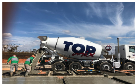
Figura 1B – Mecanização do processo em canteiro
