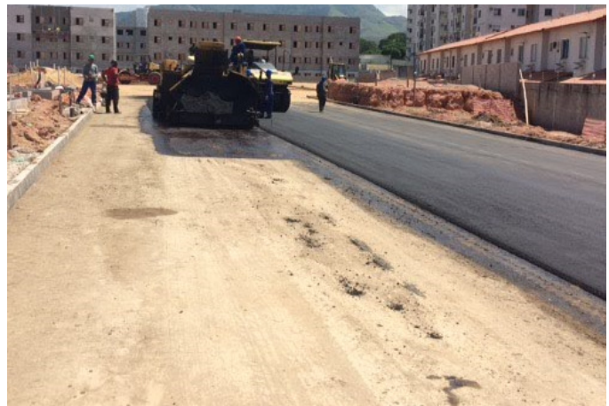
Figura 5 - Aplicação do CBUQ sobre a base
