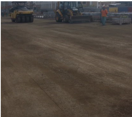
Figura 4 - Execução da base com a AS
