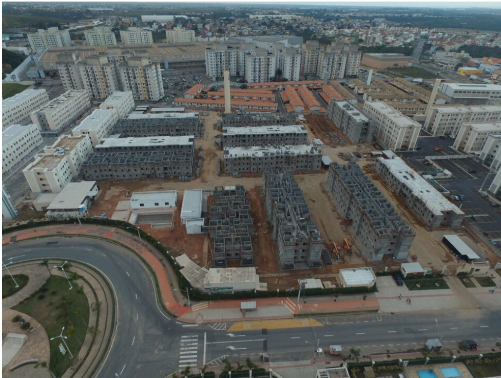
Figura 9 - Vista superior do empreendimento onde foi implantado o projeto
