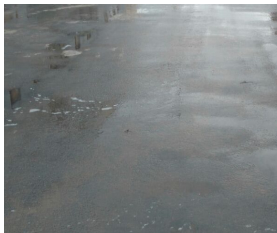
Figura 6 - Pavimentação Asfáltica executada com escória.
