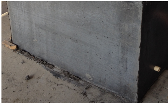
Figura 5 – Concretagem da caixa.
