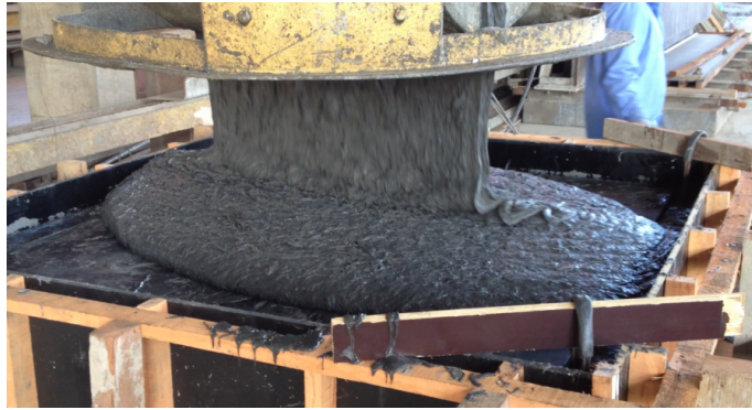
Figura 4 – Concretagem da caixa.
